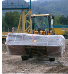
5 Festgebundener Asbest in Big-Bag oder auf Palette mit Kunststoffolie staubdicht verpackt
