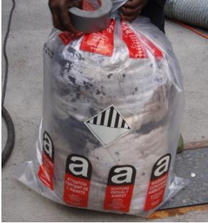
5 Festgebundener Asbest in Big-Bag oder auf Palette mit Kunststoffolie staubdicht verpackt
